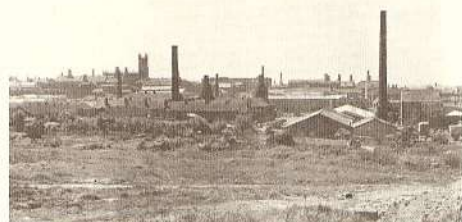
1A E 1B. VISTA DE STOKE-ON-TRENT, CENTRO PRODUTOR DE LOUÇA E CERÂMICA INGLESA, DURANTE O PERÍODO DE USO INDUSTRIAL DO CARVÃO (FINAL DO SÉCULO XIX) E DEPOIS DO ADVENTO DO GÁS E DA ELETRICIDADE (INÍCIO DO SÉCULO XX).
